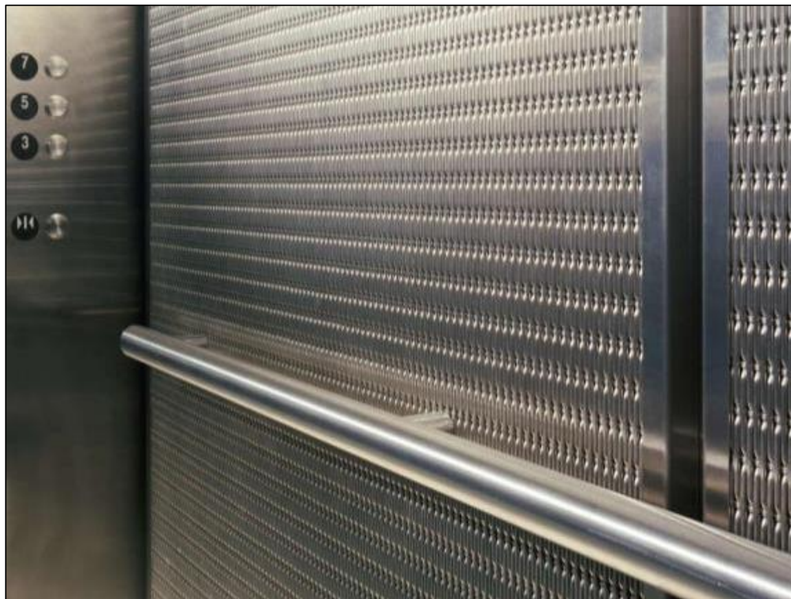
Forro con malla de inoxidable en ascensor 3
